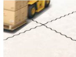
Sinüsülü X Birleşim Detayı
