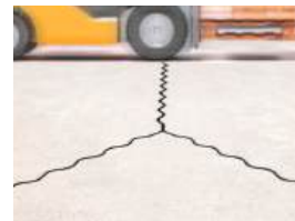
Sinüsülü Y Birleşim Detayı
